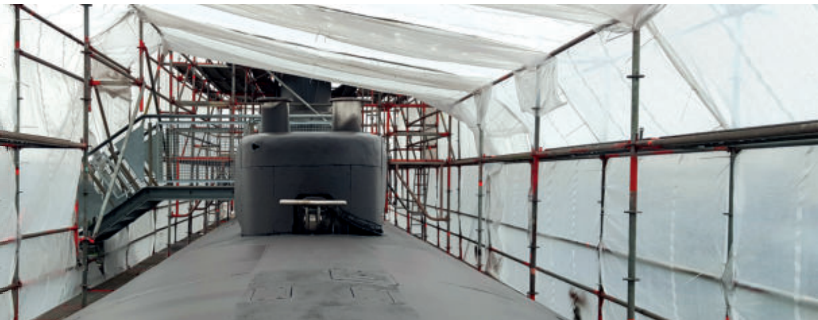
◀ Linke Seite: »Weilheim« während der Sanierungsarbeiten und eingehautes »U10« Oben: Neuer Anstrich für »U10« ▲
