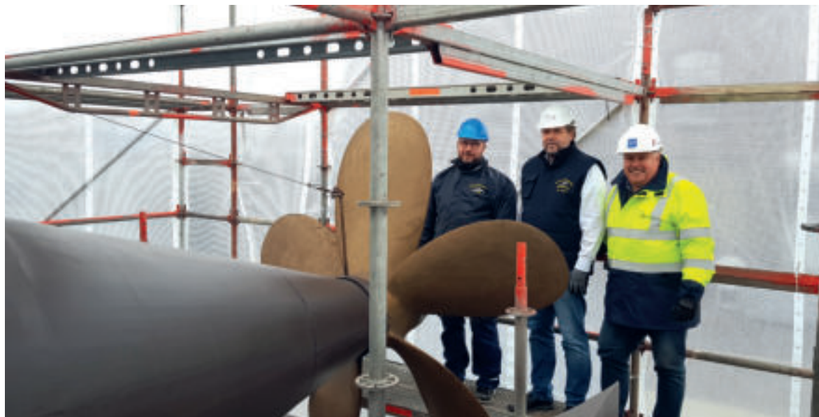
▼ Inaugenscheinnahme der Sanierungsarbeiten an »U10«
